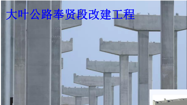
(图片来源：奉贤区首条高架桥——大叶公路城区段高架桥正式开启预制拼装施工)
